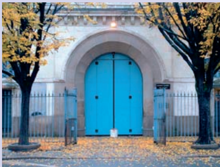
Maison d'arrêt de Nantes.
